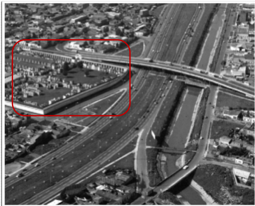
Fig.15. Vista aérea del Cementerio Norte, años ochenta, aún sin intervenir una de sus esquinas con los hornos crematorios. Fuente: La transformación de Bogotá , Hernando Durán Dussán. Villegas editores, 1990.
